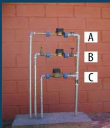
Figura G.1 – Montagem da Prova
