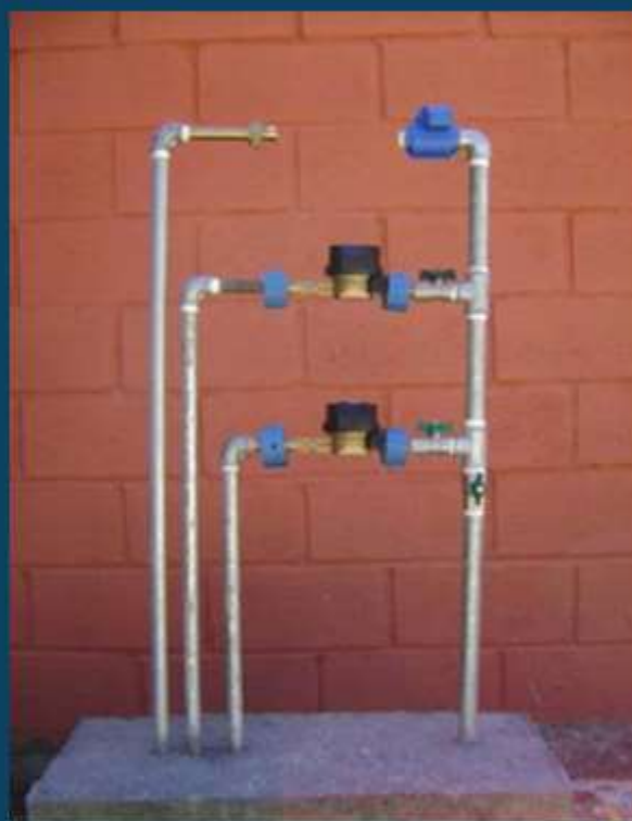
Figura G.2 – Montagem final da prova
